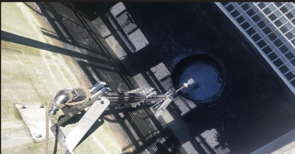
Abbildung 1: ecowirl-Installation am Einlauf in die Biologie bei geleertem Kanal
