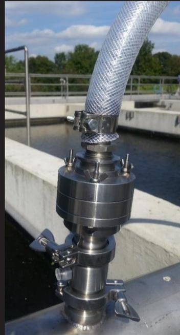
*Abbildung 2: Kreiselpumpe mit dem Grobfilter für die ecowirl-Treibwasserversorgung und ecowirl auf dem Bypass*
